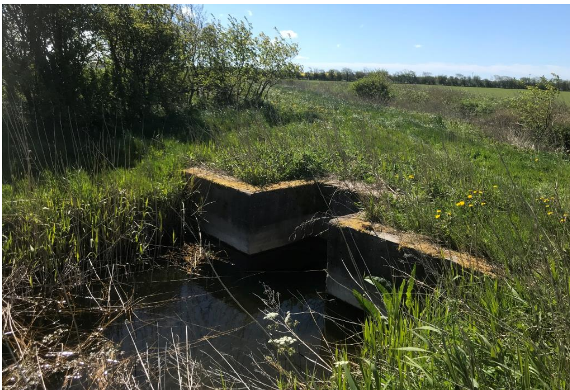
Figur 3.7.3 Betonbygværk med overfaldskant ved indløbet til det eksisterende Ø30 cm betonrør med udløb til Storå st. 3.550.
